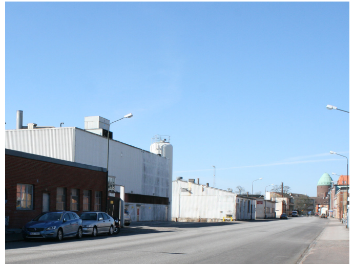
FIGUR 6. Kopperbergsgatan - del av Pågen
