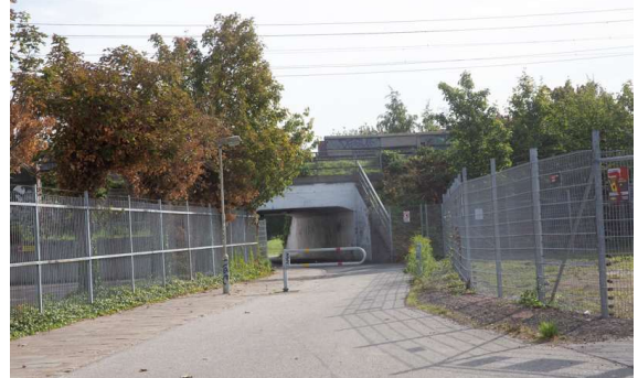
Cykelväg Norbergsgångens tunnel under kontinentalbanan
